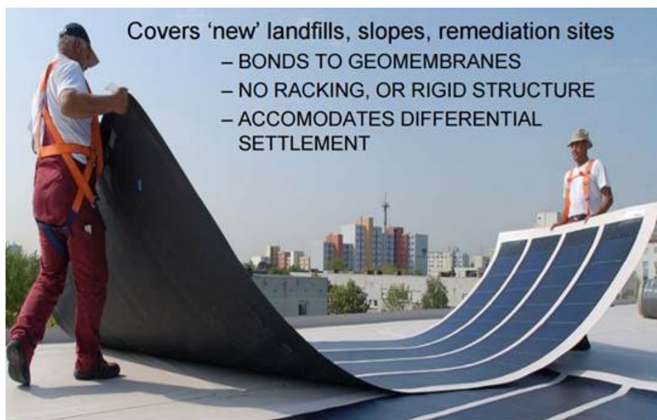
Kuva 16. Joustavan geomembraanisen aurinkopaneelin asentaminen. Lähde: http://www3.epa.gov/lmop/documents/pdfs/conf/13th/hock.pdf
